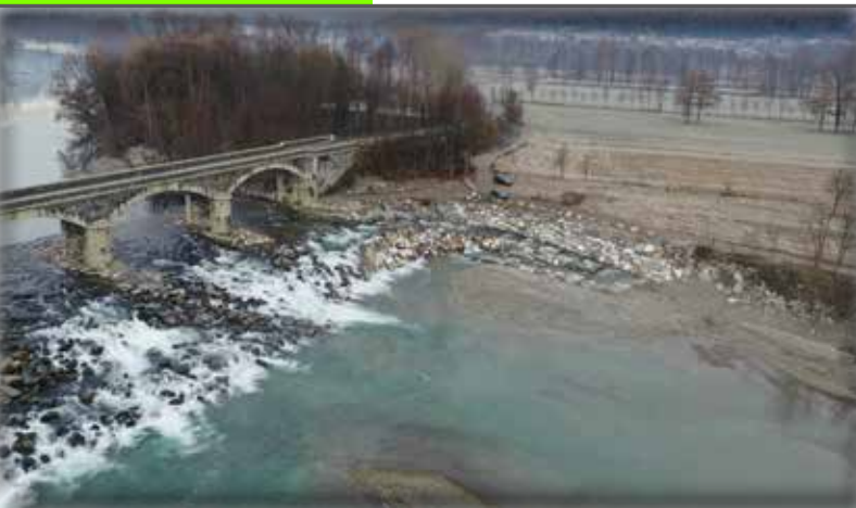
Passaggio per pesci realizzato al Ponte del Migiandone. Foto da drone (foto: GRAIA srl).
