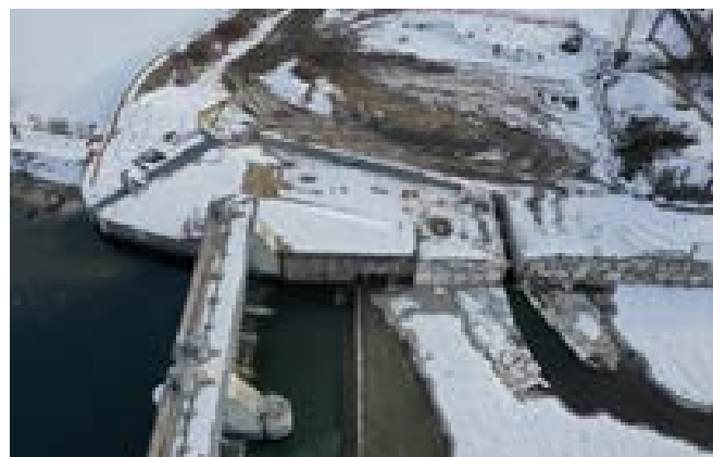
Lo sbarramento presso il Lago Tana e il passaggio per pesci costruito.
